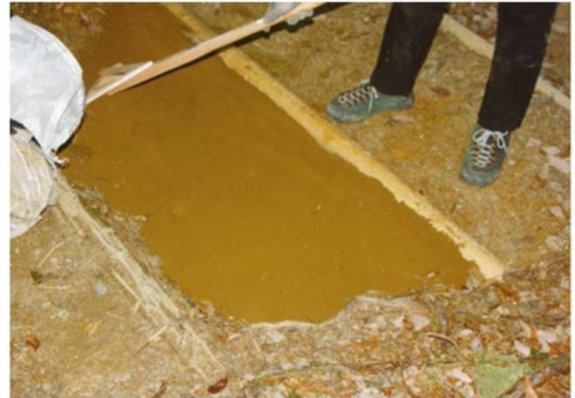
整地作業（阪和興業提供）
